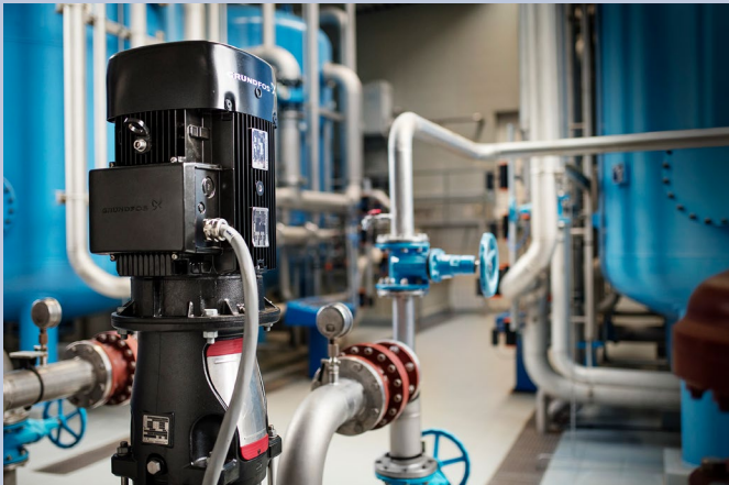
影像：奧地利 Oberwart WVSB 處的葛蘭富 CR-95 多段泵浦。在加壓/過濾應用方式中，該泵浦比其他品牌的其他舊型泵浦小得多。其可以進行傳送嗎？
