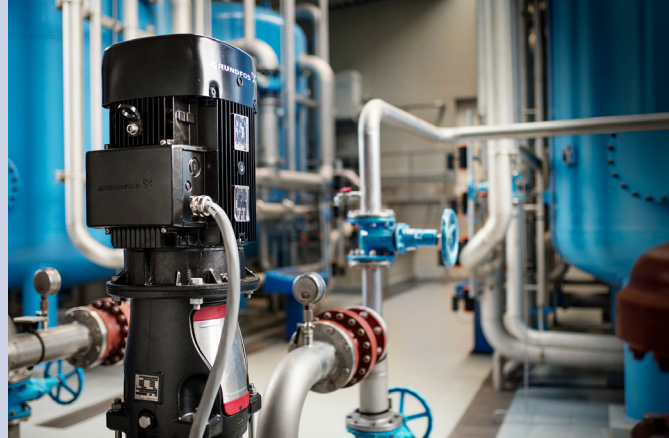
รูปภาพ: บีม Grundfos CR-95 ชนิดหลายใบพัด (multistage pump) ที่บริษัท WWSB ในโอเบอร์วาร์ท ประเทศออสเตรีย (Oberwart, Austria) บีมนี้มีขนาดเล็กกว่ามากเมื่อเทียบกับบีมเก่าที่ใช้สำหรับการเพิ่มแรงดันน้ำ (boosting)/การกรองซึ่งมาจากแบรนต์อื่น บีมจะส่งน้ำได้หรือไม่
