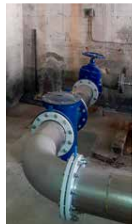
Vista en detalle de las nuevas tuberías en el interior de la estación de bombeo de la planta.
