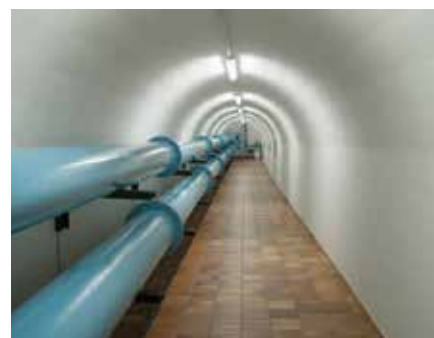
«Caverna 2», uno de los tanques elevados. La red de tuberías vertebrada los dos tanques de almacenamiento de 3.000 m 3 que abastecen el sistema del municipio.
