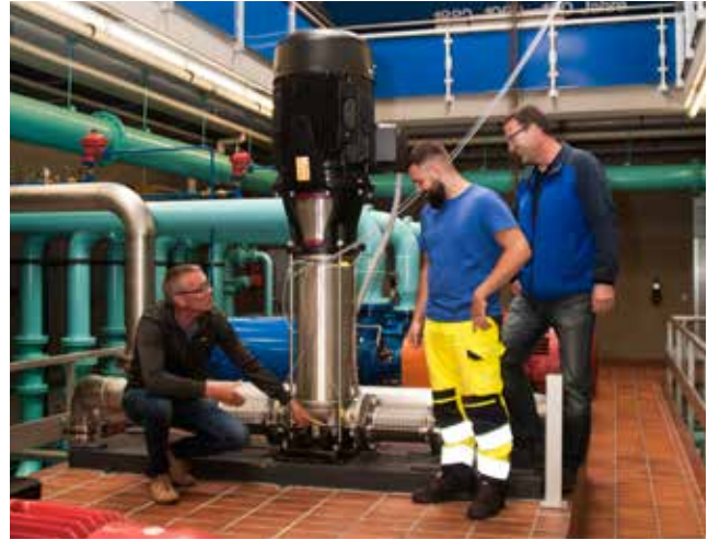
Bomba CRN 125-6 en el banco de pruebas tras el montaje.
