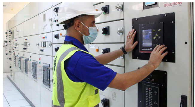
Mit einer Aufrüstung der Pumpenanlage, Dedicated Controls und einem Fernverwaltungssystem von Grundfos konnte die RAKWA 20 % Energie und 12 % der Gesamtbetriebskosten einsparen.
