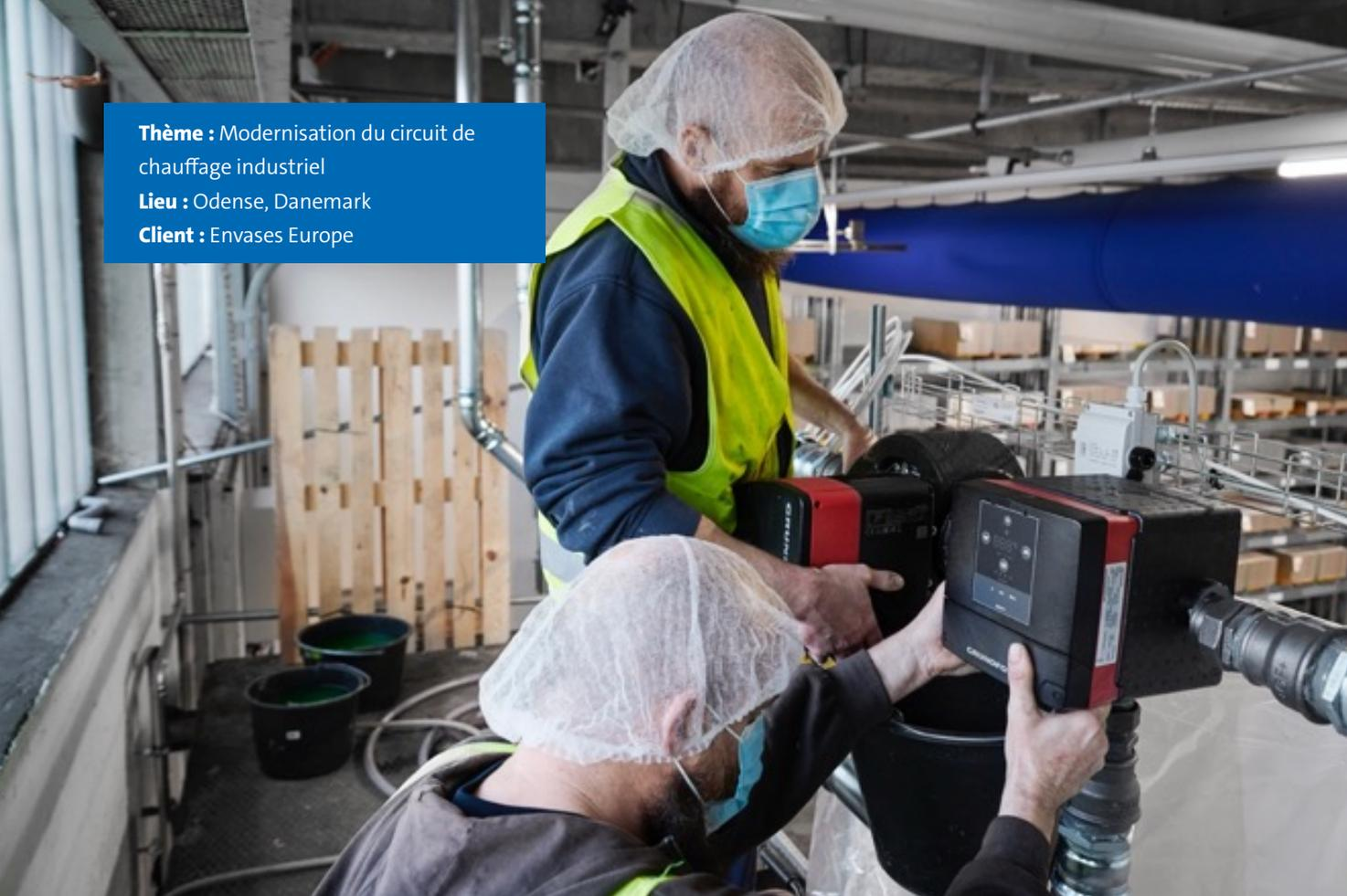
Image : Installation d'une unité MIXIT associée à une pompe de circulation MAGNA3 pour le système HVAC Envases.
