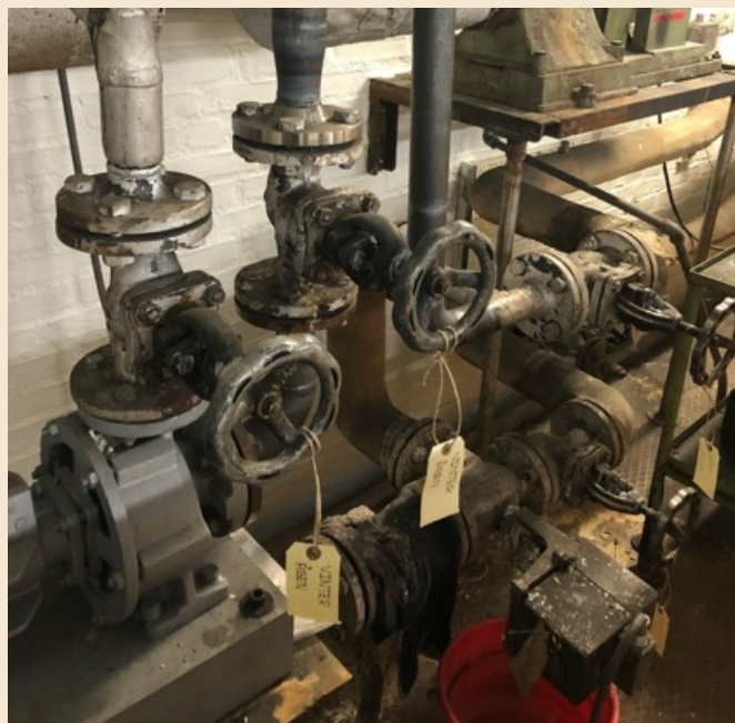
Afbeelding: Een menggroep bij Envases vóór de installatie van MIXIT.
