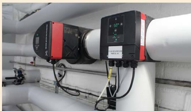
Изображение: Смесителният контур след преоборудване с MIXIT. Устройството Grundfos MIXIT е отясно, а в ляво има циркуляционна помпа Grundfos MANGA3.
