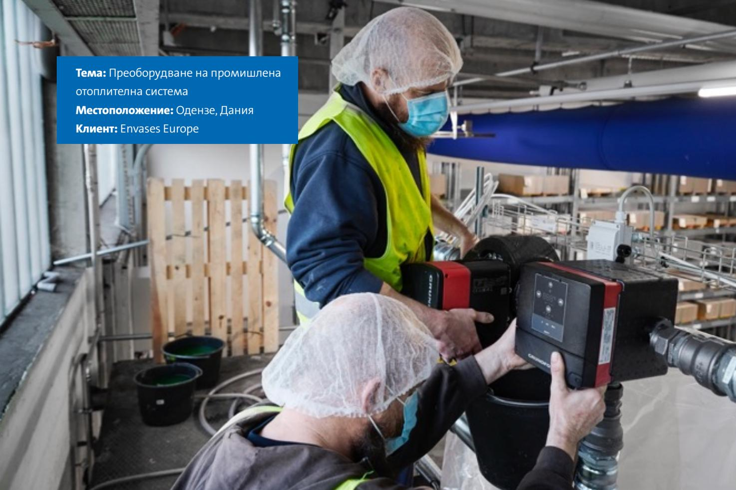
Изображение: Инсталиране на устройство MIXIT с циркуляционна помпа MAGNA3 за системата за ОВК на Envases.
