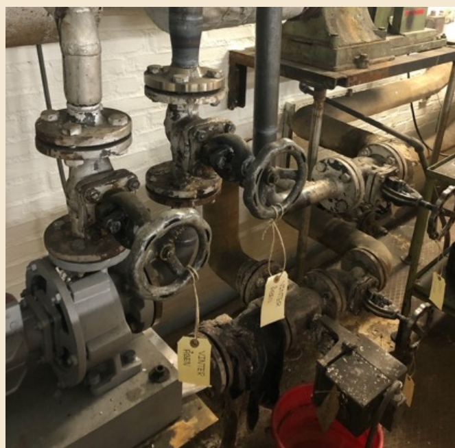
Billede: En blandesløjfe hos Envases inden eftermontering af MIXIT.
