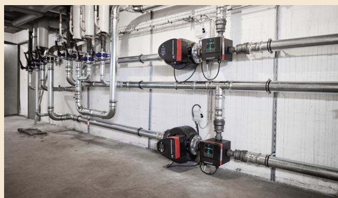
Billede: To nyinstallerede blandesløjfer med Grundfos MIXITs og MAGNA3 hos Envasers.
