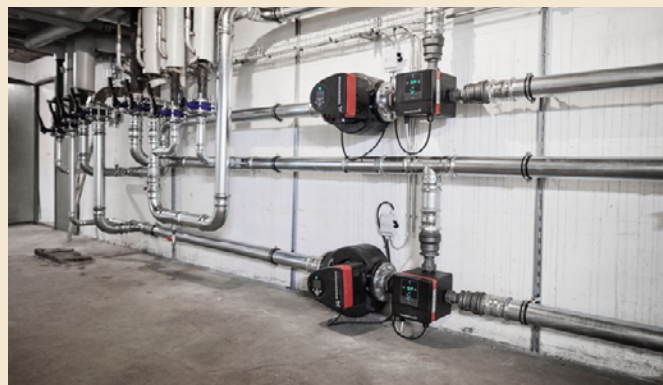
Image : Deux boucles de mélange fraîchement installées avec Grundfos MIXIT et MAGNA3 à Envas.
