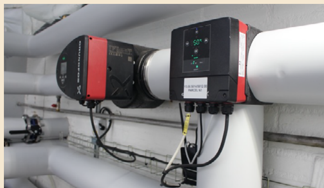
Image : La boucle de mélange après la modernisation MIXIT. À droite, l'unité Grundfos MIXIT. À gauche, une pompe de circulation Grundfos MAGNA3.
