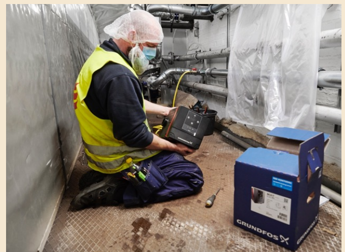
Afbeelding: De installatie van een Grundfos MIXIT bij Envases.
