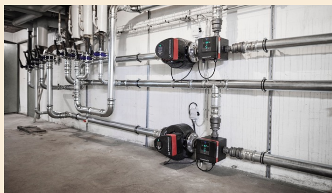
Slika: Dva upravo ugrađena hidraulička kruga sa mešanjem sa Grundfos MIXIT i MAGNA3 pumpom u Envasesu.
