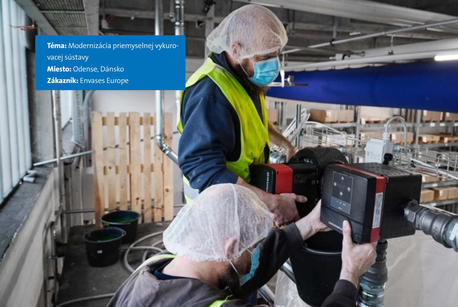
Obrázok: Inštalácia jednotky MIXIT s obehovým čerpadlom MAGNA3 pre sústavu kúrenia, vetrania a klimatizácie firmy Envases.
