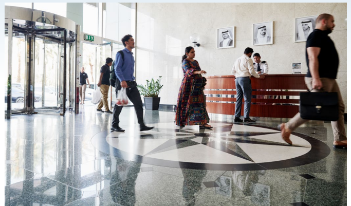
Die neuen HKL-Pumpen im Green Tower verbrauchen infolge der Nachrüstung beim Kühlen des Bürogebäudes 57 % weniger Strom als vorher.
