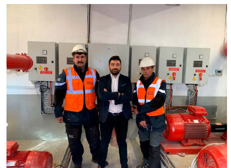
Daniel-Robert Dragomir (i midten), Service and Solutions Manager hos Grundfos Rumænien, står sammen med Grundfos-serviceteknikerne Bogdan Draghici og Dan Meluta i et rum med brandslukningsanlæg hos Dedeman.
