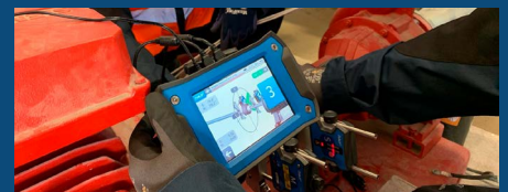
Uno strumento di allineamento laser consente di verificare che l'albero del motore e della pompa siano correttamente allineati.
