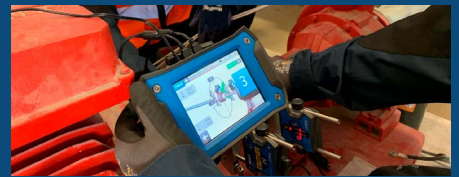
ช่างเทคนิคของ Grundfos จะให้บริการตรวจสอบเชิงระบบป้องกัน อัคคีภัยปีละสองครั้งที่ร้านค้า Dedeman - ผู้ค้าปลีกผลิตภัณฑ์ ตกแต่งซ่อมแซมบ้านแบบ DIY รายใหญ่ที่สุดของโรมาเนีย
