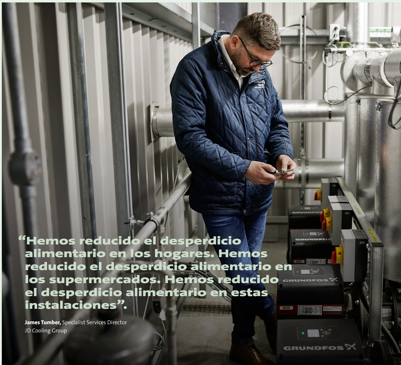
James Tumber comprueba el estado de las bombas de circulación principales Grundfos NBE para glicol detrás del sistema Softripe mediante una app móvil.
