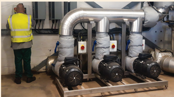
Các máy bơm NB mới cho nước làm mát
