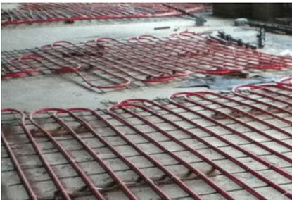
Le refroidissement fourni à travers le plancher est le plus efficace en cas de fort rayonnement solaire, puisque le plancher rafraîchissant peut plus facilement absorber ces charges que le plafond. Par rapport aux panneaux, les dalles réfrigérées offrent une inertie thermique plus importante et peuvent donc mieux tirer profit des variations de température extérieure.
