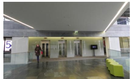
*Exemple d'un plafond rafraîchissant en placoplâtre. Ici, les tuyauteries d'eau glacée sont fixées à l'arrière des panneaux. La température de surface du plafond ne doit pas être inférieure au point de rosée de l'air dans la pièce.*
