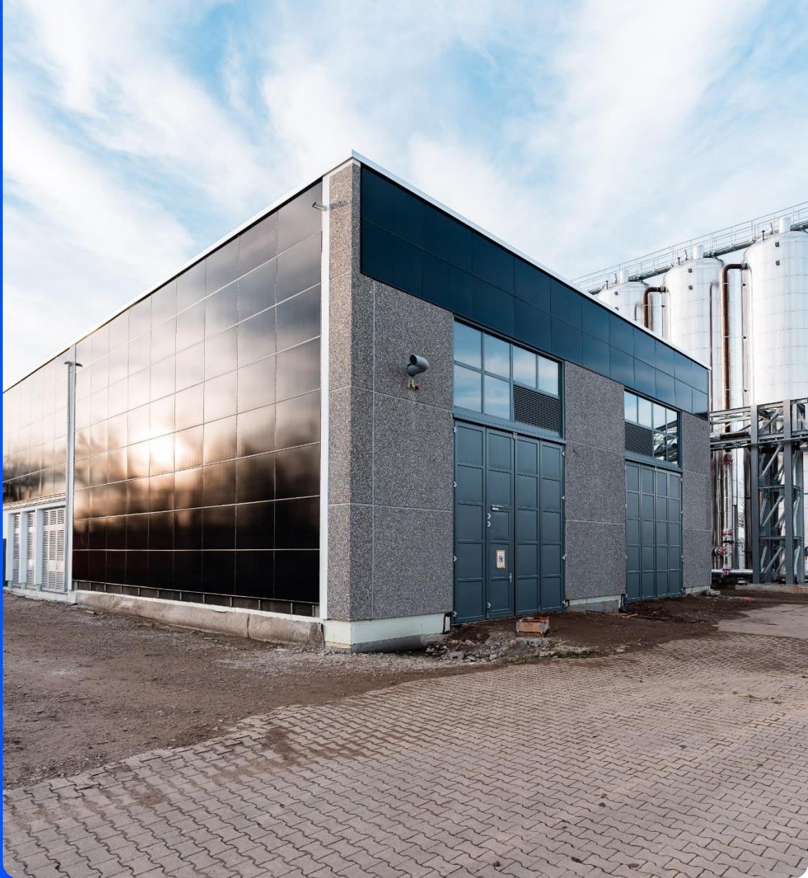
Abbildung 1: Energiezentrale Cerdia. Quelle: Badenova
