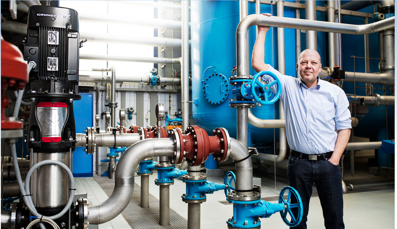
Christian Portschy steht neben der Pumpe CR 95 von Grundfos für die Wasserdruckerhöhung. Portschy ist Geschäftsführer beim Wasserverband Südliches Burgenland (WVSB), dem Wasserversorger in Oberwart, Österreich.
