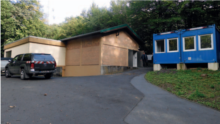
Wassergewinnungsgebiet Farnwiese mit Brunnenstuben und Entsäuerungsanlage sowie Speicheranlagen
