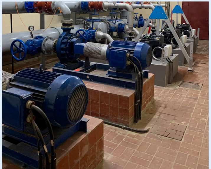
DEA in der Umbauphase – Alte Pumpentechnik vorne, 3 neue NBE 65-200/198 hinten, Bauzustand Juni 2022
