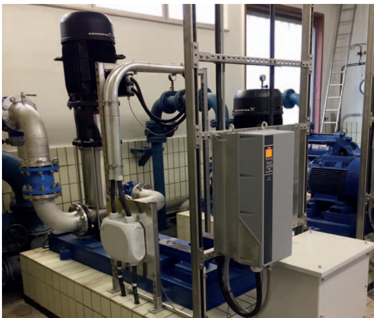
Schritt für Schritt werden die Altpumpen gegen die neuen CR 125-4 – im laufenden Betrieb – ausgetauscht.
