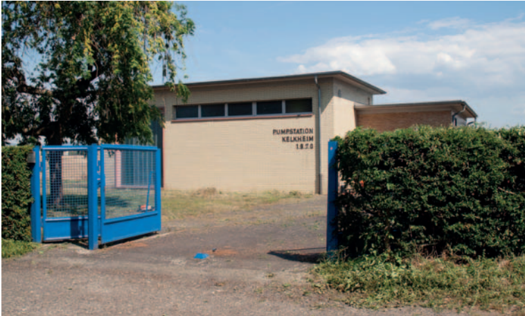
Das Pumpwerk Kelkheim leistet seit 1970 einen wesentlichen Beitrag für die Versorgung der Bevölkerung mit frischem Trinkwasser. Bei der Errichtung der Anlage war es noch das Pumpwerk Kelkheim
