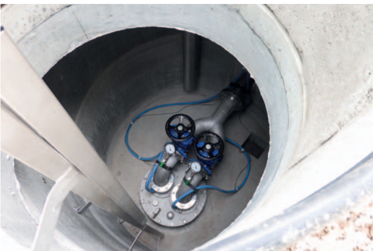
SP-Brunnenpumpe nach der Montage
