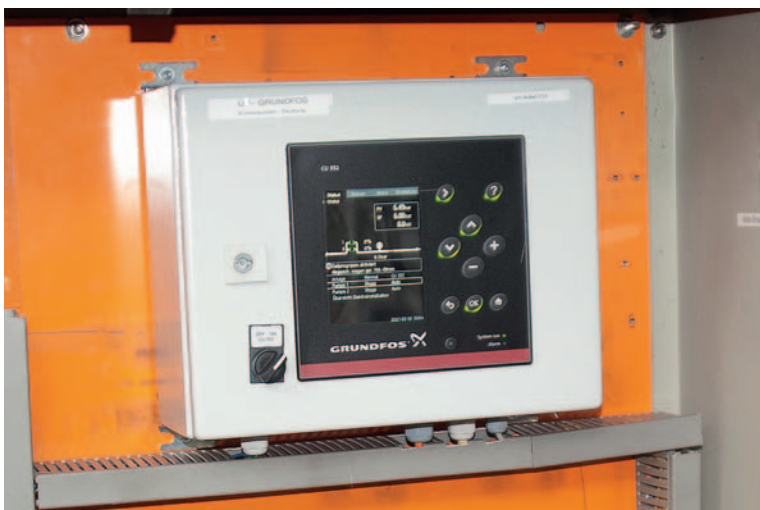
Steuerung CU 352 in Kombination mit zwei SP 95-6 sichern optimale und effiziente Wasserversorgung
