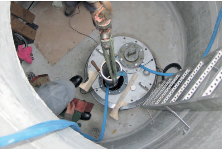
Trockenbohrung DN 900 mit einer Bohrtiefe von 31,5 m
