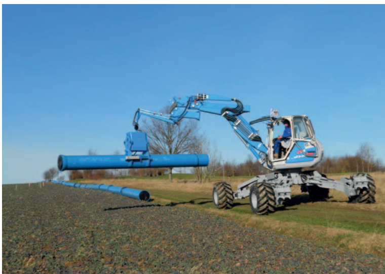
Rohrverlegung in offener Bauweise. Ein Spezialfahrzeug verlegt die DN 500 Rohre mit einem von der Fa. Norbert Schütz entwickelten Verfahren
