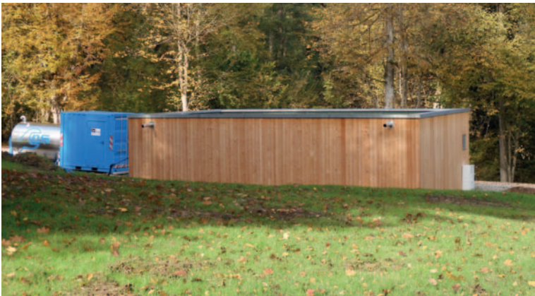
Am Übergabebauwerk in Wemding: Die mobile DEA ist vom LKW abgesetzt worden. Alle Anschlüsse wurden hergestellt. Zu diesem Zeitpunkt wurde Wasser zur Herstellung von Ort beton zur Bahnunterquerung Donauwörth-Treuchtlingen gefördert.
