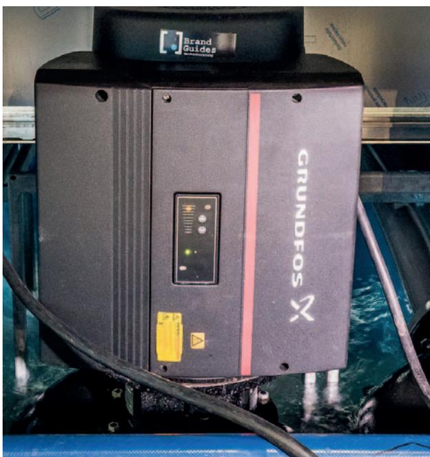
NBE150 mit integriertem Frequenzumrichter bietet optimalen Bedienkomfort
