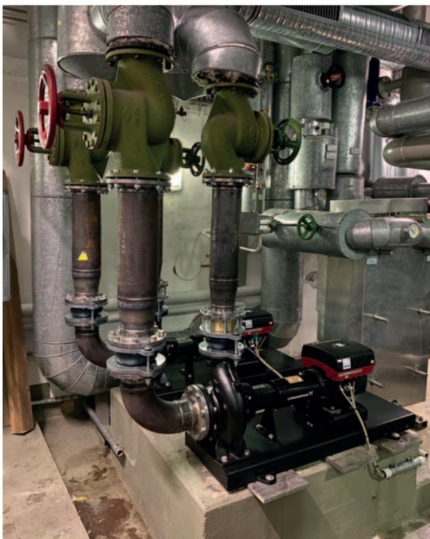
Mit den neu installierten NKE-Pumpen von Grundfos reduziert die Unternehmensgruppe ihren Strombedarf pro Jahr um rund 8000 kWh; bei einem Strompreis von 0,18 €/kWh spart er über den Lebenszyklus von 15 Jahren ca. 21.300 Euro Energiekosten ein. Zum Austausch der Pumpen war eine Anpassung der Rohrleitungen erforderlich - saug- und druckseitige Rohrleitungsänderungen mit vorgefertigten Passstücken.
