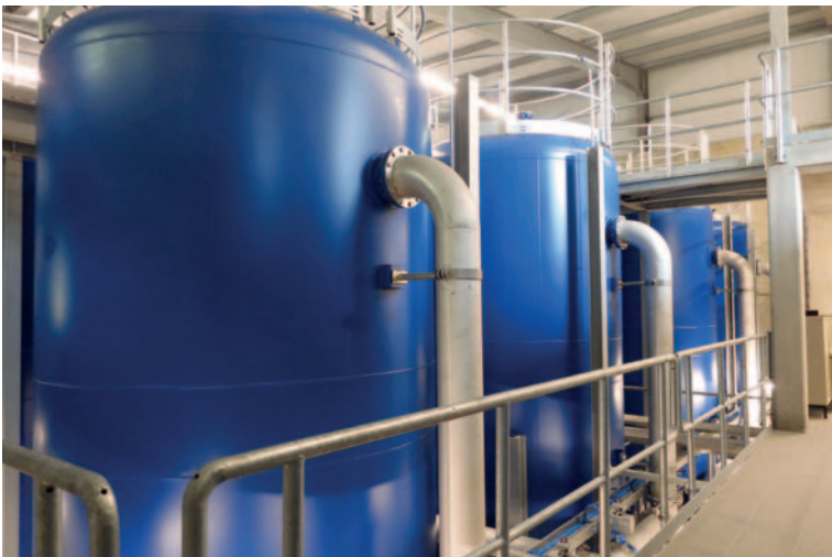
Aktivkohlefilter der 4. Reinigungsstufe in 6 Straßen mit jeweils 2 Filterbehältern Q max ist 90 l/sec
