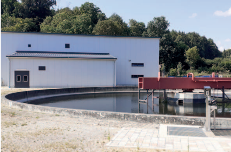
Das Gebäude für die 4. Reinigungsstufe wurde 2019 fertiggestellt. Im Vordergrund die Nachklärung
