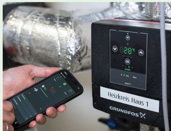
Η ασύρματη διεπαφή καθιστά εφικτή τη θέση σε λειτουργία και την παρακολούθηση της μονάδας ελέγχου MIXIT χρησιμοποιώντας την εφαρμογή Grundfos GO Remote.
