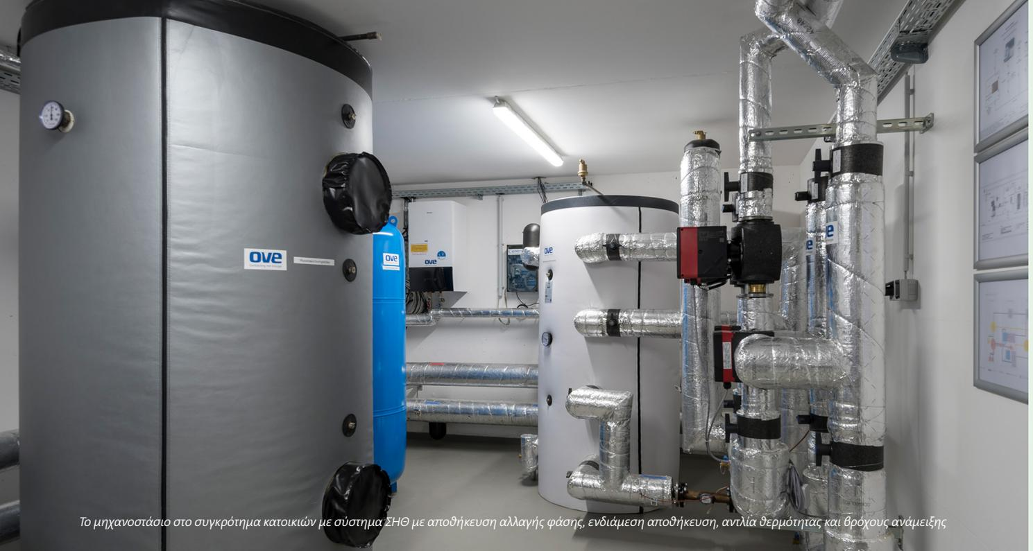
Το μηχανοστάσιο στο συγκρότημα κατοικιών με σύστημα ΣΗΘ με αποθήκευση αλλαγής φάσης, ενδιάμεση αποθήκευση, αντλία θερμότητας και βρόχους ανάμειξης
