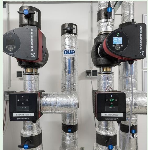
Βρόχοι ανάμειξης για τη φάση κατασκευής 1 (δεξιά) και 2 (αριστερά), κάθε ένας με μονάδα ελέγχου MIXIT και κυκλοφορητή δευτερεύοντος κυκλώματος MAGNA3.
