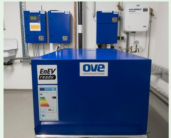
Η κύρια γεννήτρια θερμότητας είναι ένα συμπαγές σύστημα ΣΗΘ με 21 kW θερμικής ισχύος και 9 kW ηλεκτρικής ισχύος.
