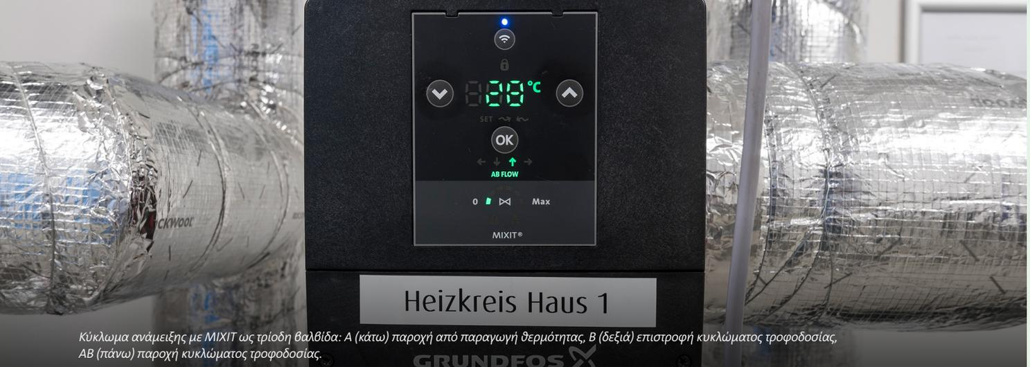
Κύκλωμα ανάμειξης με MIXIT ως τριόδη βαλβίδα: Α (κάτω) παροχή από παραγωγή θερμότητας, Β (δεξιά) επιστροφή κυκλώματος τροφοδοσίας, ΑΒ (πάνω) παροχή κυκλώματος τροφοδοσίας.
