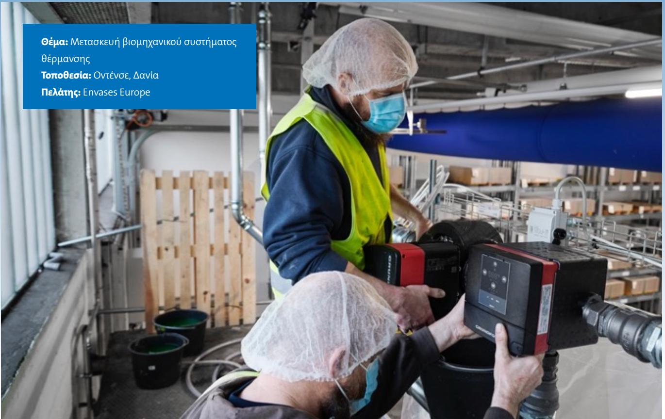
Εικόνα: Εγκατάσταση μιας μονάδας MIXIT δίπλα σε έναν κυκλοφορητή MAGNA3 για το σύστημα HVAC της Envas.
