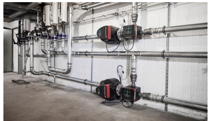
Εικόνα: Δύο πρόσφατα εγκατεστημένοι βρόχοι ανάμειξης με Grundfos MIXIT και MANGA3 στην Envases.
