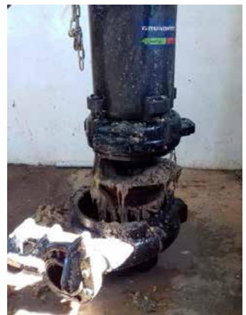
Un ejemplo de atasco en una de las bombas antiguas.
