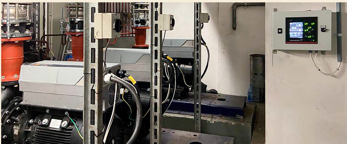
Después: reemplazar las cinco bombas originales con tres bombas Grundfos NBE y controlador MPC trajo un nuevo nivel de eficiencia al sistema de enfriamiento.
