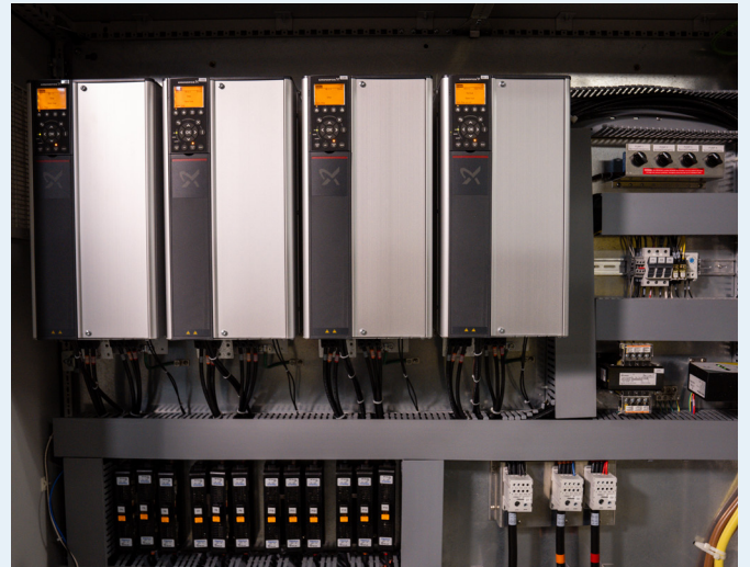
Hydro MPC Quadruplex on muutuva kiirusega kompaktne pumbajaam, mis koosneb neljast pumbast, mootoritest, sagedusmuunduritest ning CU 352 juhtkontrollerist
