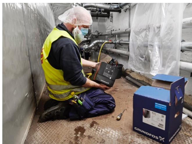
Kuva: Grundfosin MIXIT-yksikköä asennetaan Envases-yhtiön tiloihin Odensessa, Tanskassa.
