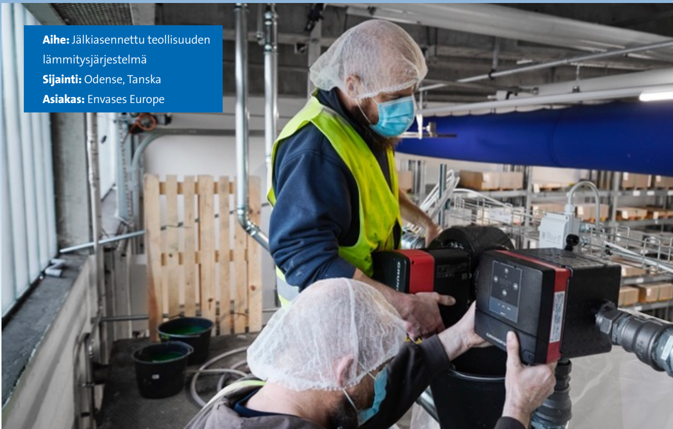
Kuva: MIXIT-yksikköä ja MAGNA3-kiertovesipumppua asennetaan Envases-yhtiön LVIK-järjestelmään.
