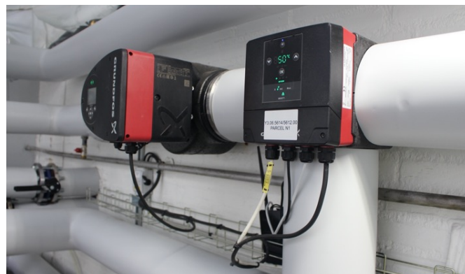
Kuva: Sekoituspääpiiri, kun MIXIT-ratkaisu on jälkiasennettu järjestelmään. Grundfosin MIXIT-yksikkö on oikealla, ja Grundfosin MAGNA3-kiertovesipumppu on vasemmalla.
