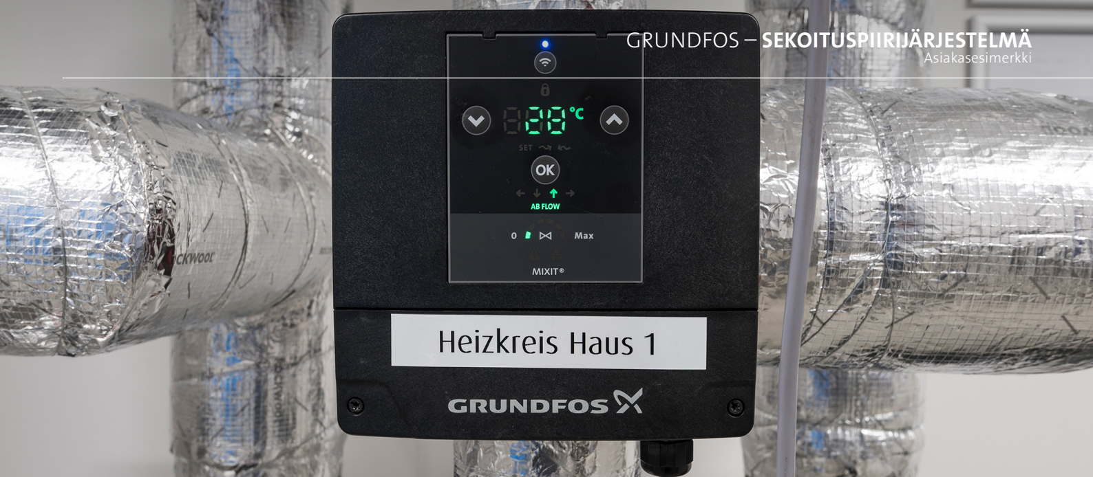
MIXIT-sekoituspiiri, jossa on 3-tieventtiili: A (alas) lämmöntuotannosta tuleva virtaama, B (oikealle) syöttöpiirin paluuvirtaama, AB (ylös) syöttöpiirin menovirtaama.
