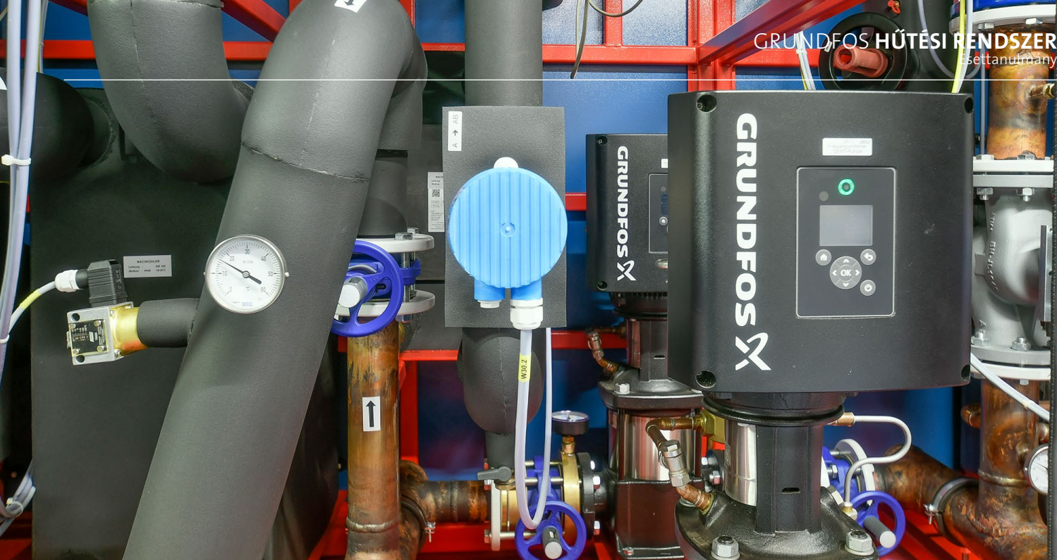
A nagy hatékonyságú SEW hővisszanyerő rendszer szerelvénycsoportja
