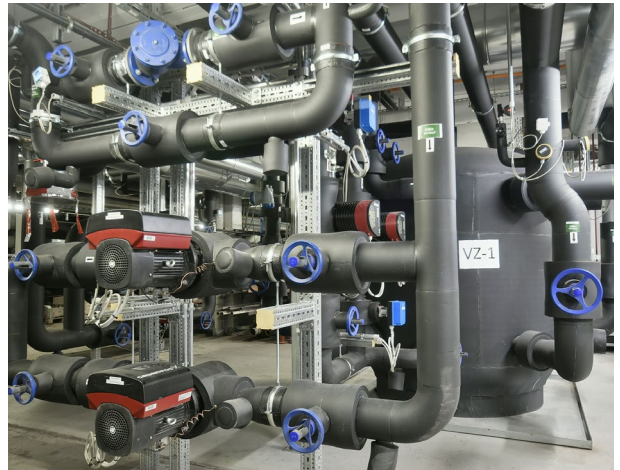
Új hideg energiaellátó központ a három Zortström elosztó és hidegszivattyú egyikével
