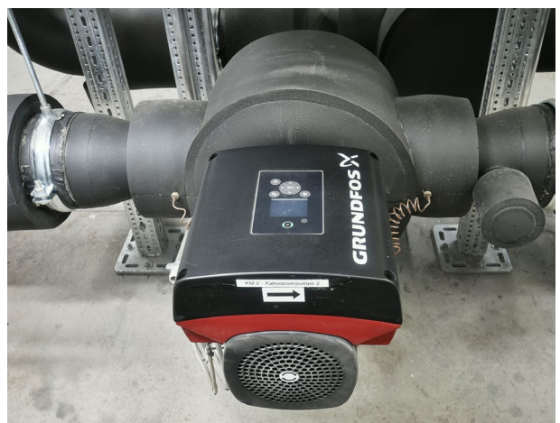
Nagy hatékonyságú in-line szivattyú a TPE sorozatból
