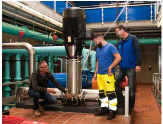
La CRN 125 - 6 viene testata sul campo al momento dell'assemblaggio.
