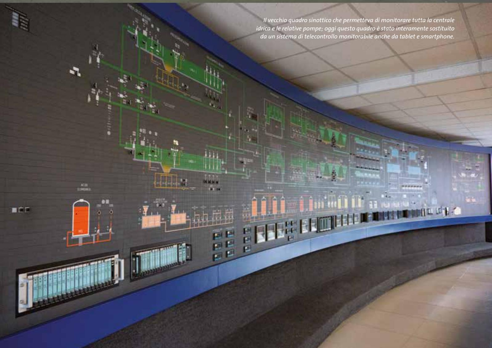
*Il vecchio quadro sinottico che permetteva di monitorare tutta la centrale idrica e le relative pompe; oggi questo quadro è stato interamente sostituito da un sistema di telecontrollo monitorabile anche da tablet e smartphone.*
