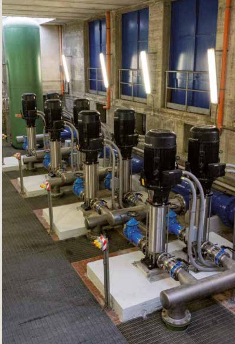
*In ognuna delle quattro postazioni del vecchio impianto di rilancio sono state collocate due pompe centrifughe verticali multistadio Grundfos funzionanti in parallelo, per un totale di otto dispositivi azionati in base ai livelli richiesti nel serbatoio a valle di Riveggio.*
