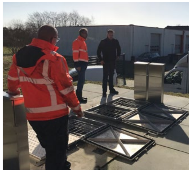
L'Operations Manager Ivo ten Brinke (a destra) mostra soddisfatto la nuova stazione di pompaggio.
