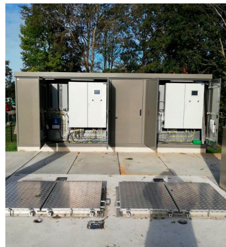
Pompy są napędzane przez napędy o zmiennej prędkości obrotowej.
