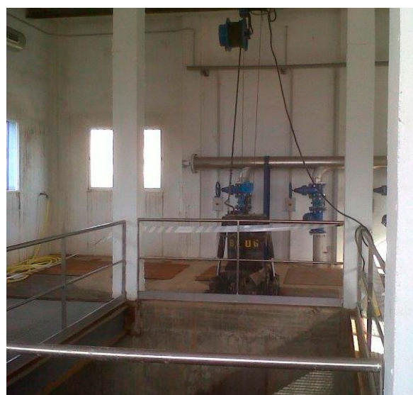
Spojrzenie na przepompownię.
