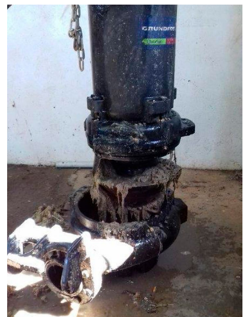
Przykład zatkania w jednej ze starych pomp.
