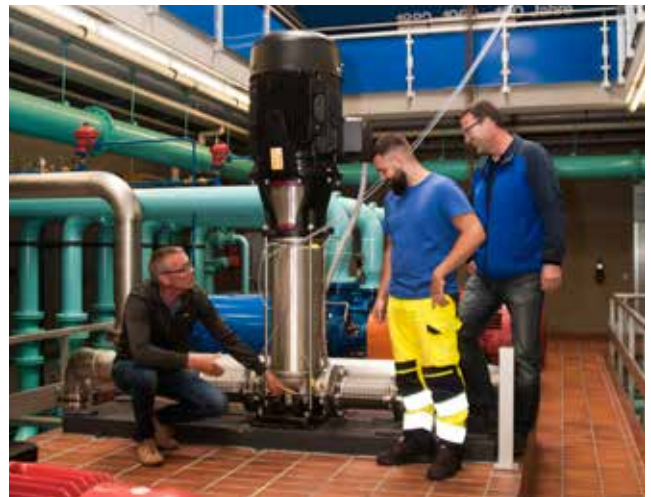
A CRN 125-6 está a ser testada num teste após montagem.
