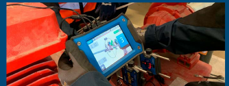
Un tehnician de service Grundfos în curs de realizare a unei verificări anuale de service pentru protecția împotriva incendiilor la un magazin Dedeman – cel mai mare retailer de produse de bricolaj pentru amenajarea locuinței din România.
