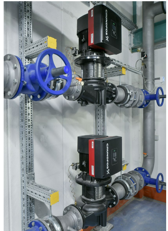
Sistem de pompare pentru pomparea apei de răcire la turnul de răcire de tip uscat
