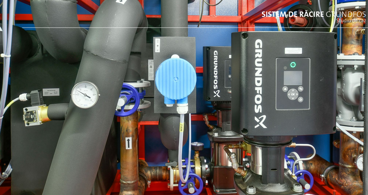
Grup de fittinguri din sistemul de recuperare a căldurii SEW de înaltă eficiență
