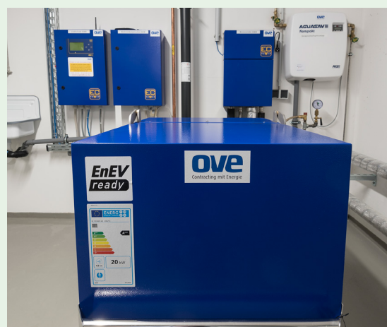
Principalul generator de căldură este un sistem compact CHP cu putere termică de ieșire de 21 kW și putere electrică de ieșire de 9 kW.
