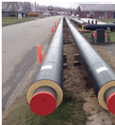
Трубы центрального отопления, подготовленные к укладке.
