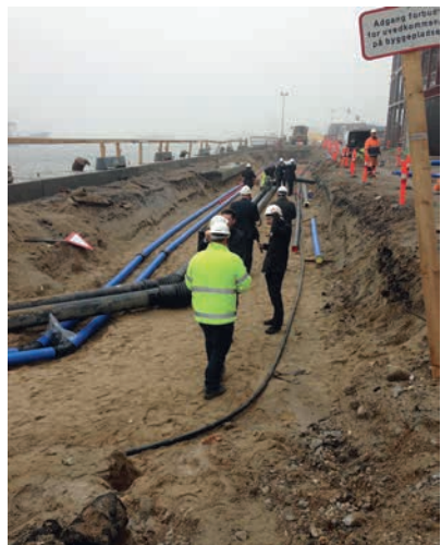
Новые трубы готовы к укладке в промышленной зоне.
