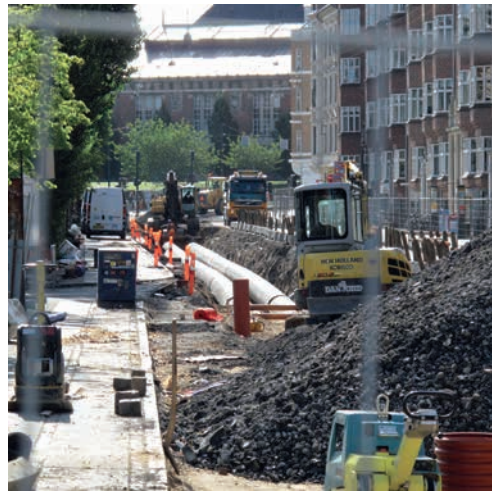
Прокладка теплотрассы системы ЦО через центр города.
