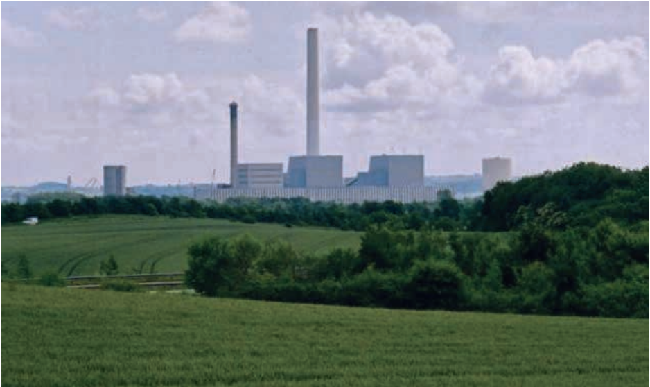
ТЭЦ в Студструпе (пригород г. Орхус, Дания) рассчитана на электрическую мощность до 350 МВт и тепловую мощность до 455 МВт (3,43 млн Гкал в год). Крайнее строение справа — резервуар ТЭЦ объемом 33 000 м 3 .
