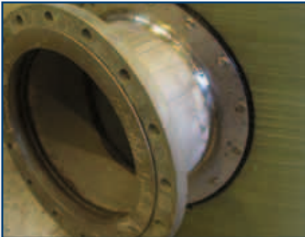
Уплотнительная манжета на входах в резервуары различных диаметров (включая болты и т. п.)
