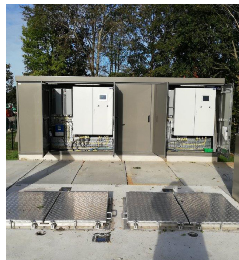
Pumparna drivs med frekvensomformare.
