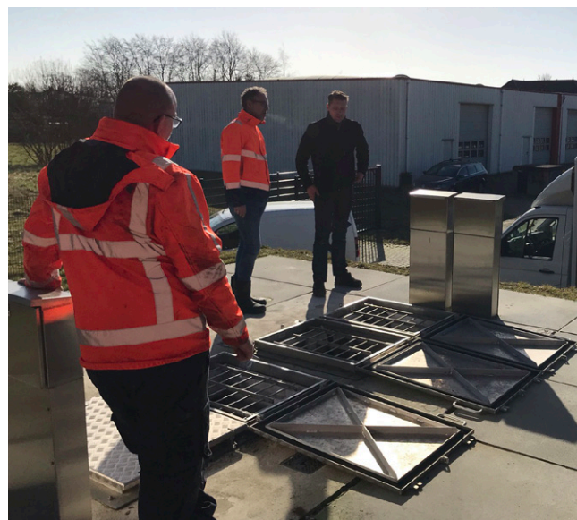
En nöjd verksamhetschef, Ivo ten Brinke (till höger), visar runt i den nya pumpstationen
